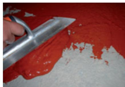
**ICOPER-HP cumple con la norma armonizada EN 14891: protege terrazas y balcones contra el agua de lluvia y evita la propagación de grietas incluso en condiciones climáticas desfavorables.**
