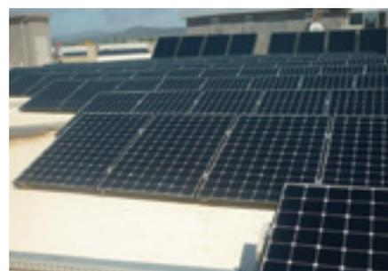
L'utilisation d'ICOPER MULTIUSO, classé BROOF (t4), permet aux toitures d'obtenir les performances au feu requises pour l'installation d'un système photovoltaïque.
