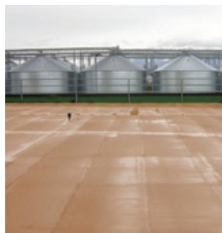
**ICOPER MULTIUSO, conformément à la norme EN 13583 : 2012 « DÉTERMINATION DE LA RÉSISTANCE À L'IMPACT SIMULÉ DE LA GRÊLE », confère au système de toiture une résistance à la grêle H1-H7 selon l'Échelle Torro.**
