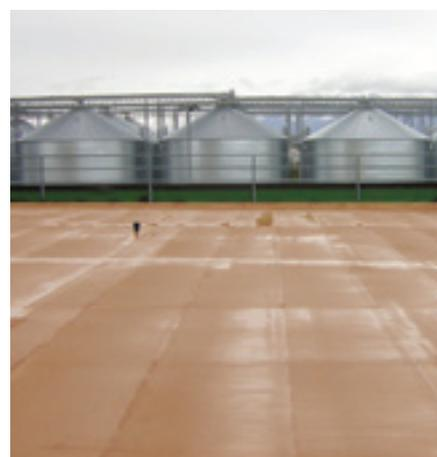
**ICOPER MULTIUSO transmite al sistema de cubierta una resistencia al granizo hasta H7 en la Escala Torro, de acuerdo con la Norma Europea EN 13583: 2012 "Determinación de la resistencia al granizo".**
